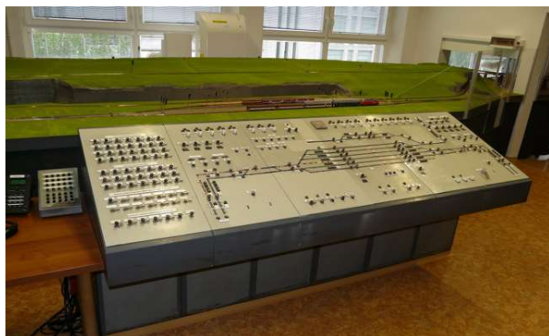
Obr. 4 Reléové zabezpečovací zařízení
