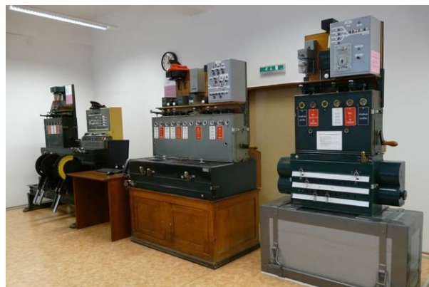
Obr. 3 Elektromechanické zabezpečovací zařízení
